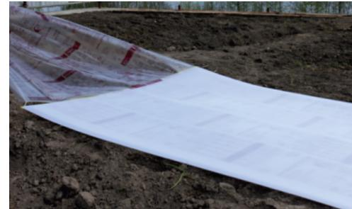
1. Разложить лист сотового поликарбоната. Снять защитную пленку до монтажа. Наружный слой сотового поликарбоната с УФ-защитой должен располагаться сверху.
