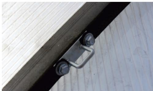
21. Дополнительно закрепить на дугах скобы внутри теплицы если они входят в комплект, чтобы можно было протянуть проволоку и подвязывать растения.
