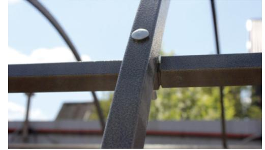
14. Перемычки (стяжки) крепятся к дугам на болты. В отличие от крепления на саморезах каркас на болтах точно такой же надежный как при качественной сварке.
