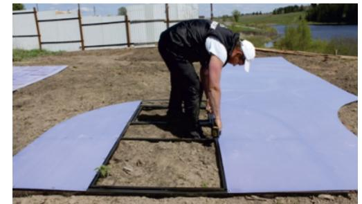
6. Развернуть лист поликарбоната, уложить его на противоположную сторону. Аналогично закрепить саморезами и отрезать лишнюю часть по краю.
