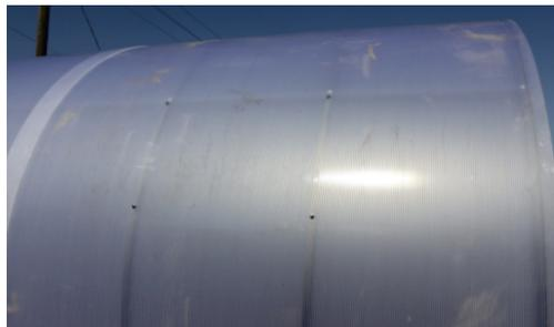
20. Крыша должна быть хорошо натянута без провисов. Саморезами закреплять с шагом не более 50 см.
