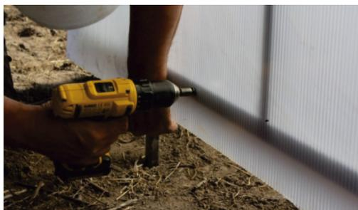
19. Сначала закрепить хорошо натянутый поликарбонат внизу. Затем закреплять поликарбонат на дугах.
