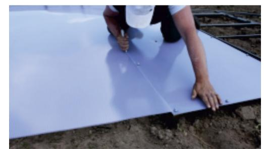
5. Отрезать столярным ножом с плоским лезвием строго по контуру фронтона лишний поликарбонат.
